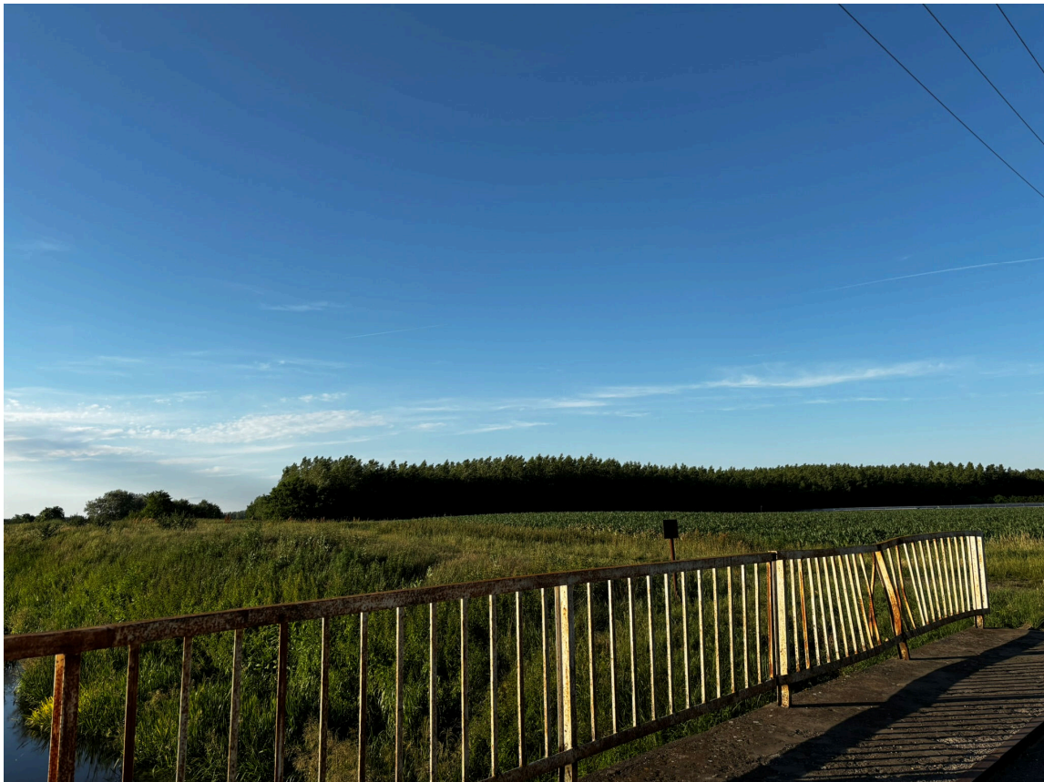
0199 hrsz-ú csatorna északi irányba, jobb part, kezelősáv, 0205/2 hrsz-ú terület
