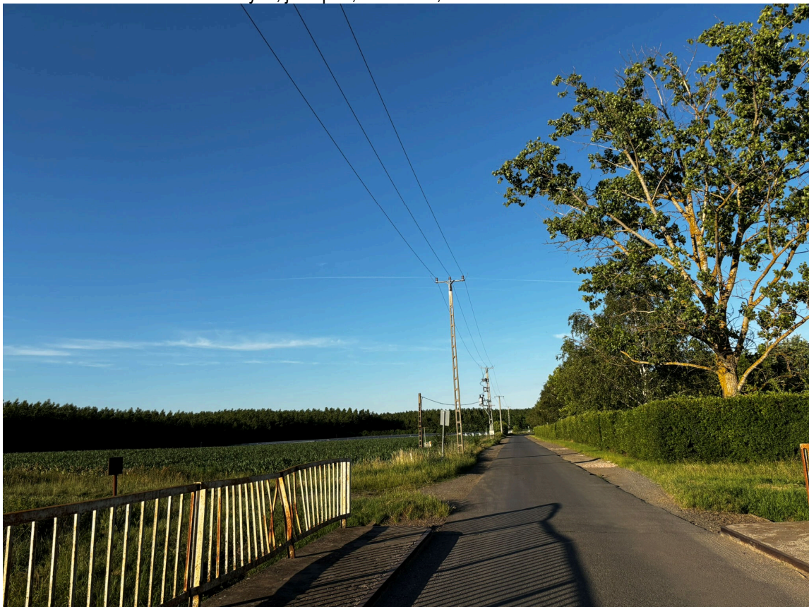
0204 hrsz-ú út, bal oldat a 20 kV-os trafó és a tervezési terület
